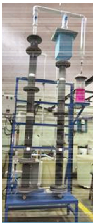
Figure 2 : Actual BioMOD EGSB reactor
